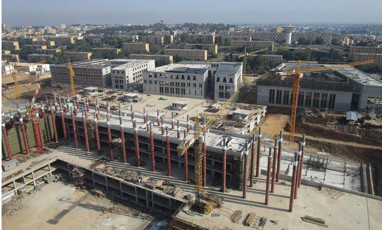
Rohbau Koranschule, Bibliothek, Konferenzzentrum | Oktober 2015
