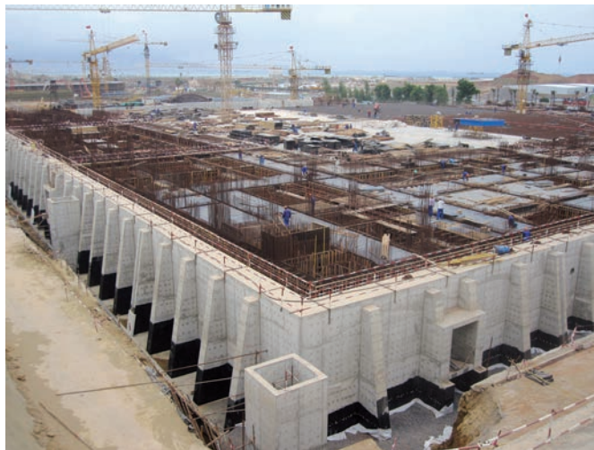
Bild 10 Rohbauarbeiten Untergeschoss Gebetsaal (08/2014) Construction work basement prayer hall (08/2014)
