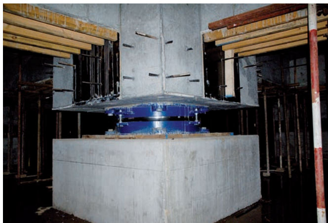
Bild 12 Eingebauter Isolator Built in isolator
