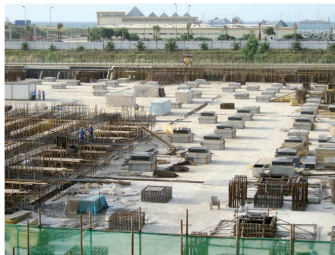
Bild 11 Bodenplatte mit montierten Isolatoren Foundation plate with placed isolators
