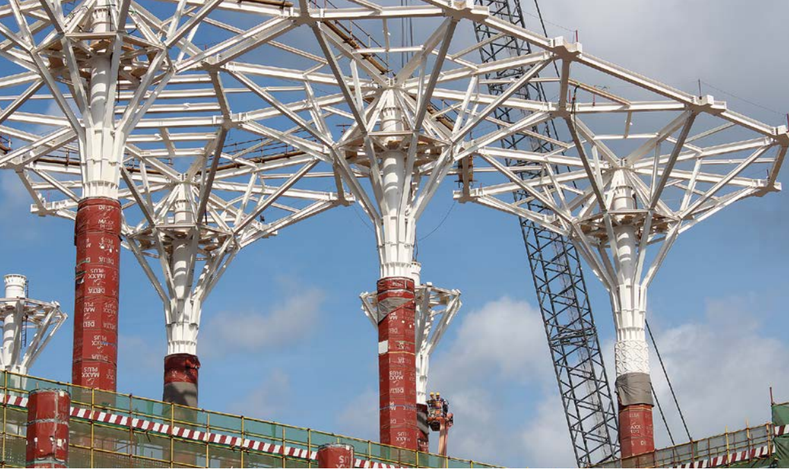
Gebetsaal - Stahlkapitelle | Oktober 2015 (oben) Baustelle Minarett von Nordwesten | Oktober 2015 (rechts)
