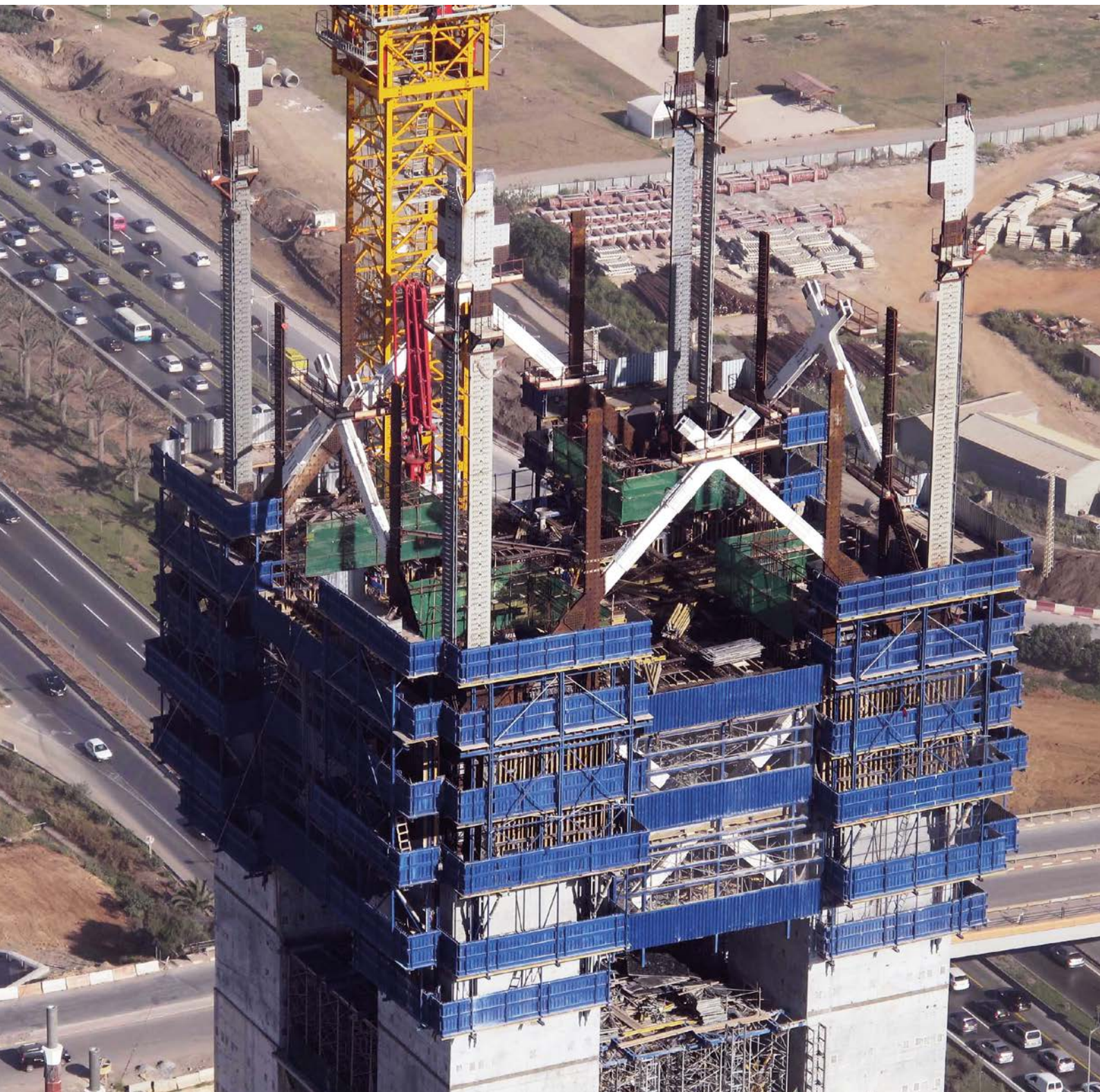
Minarett im Rohbau | Oktober 2015
